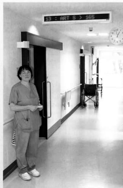
Das Pflegepersonal kann sofort erfassen, weshalb ein Alarm ausgelöst worden ist und wo.
